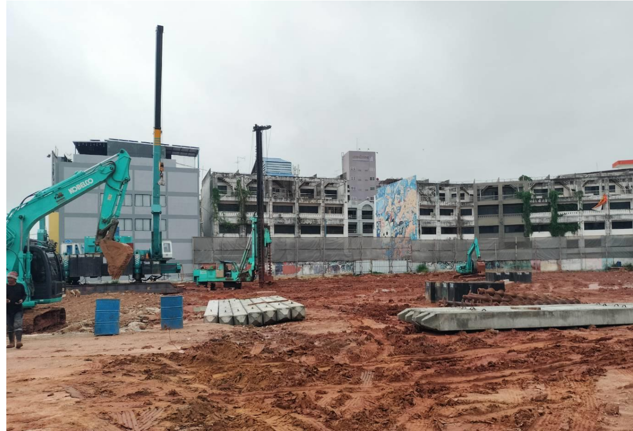
ก่อสร้างศูนย์การค้า JAS (ขอนแก่น)
