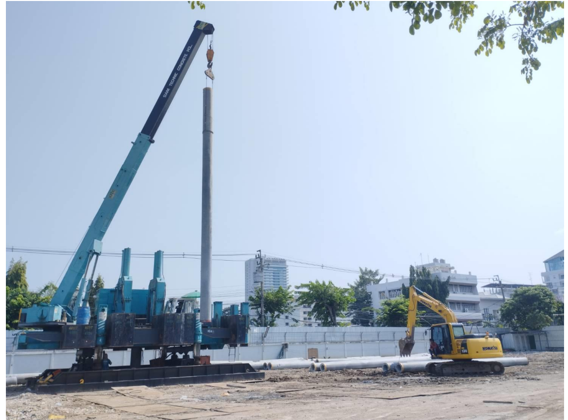
ก่อสร้างอาคารพักข้าราชการกองทัพเรือ บางกอกน้อย (กทม.)
