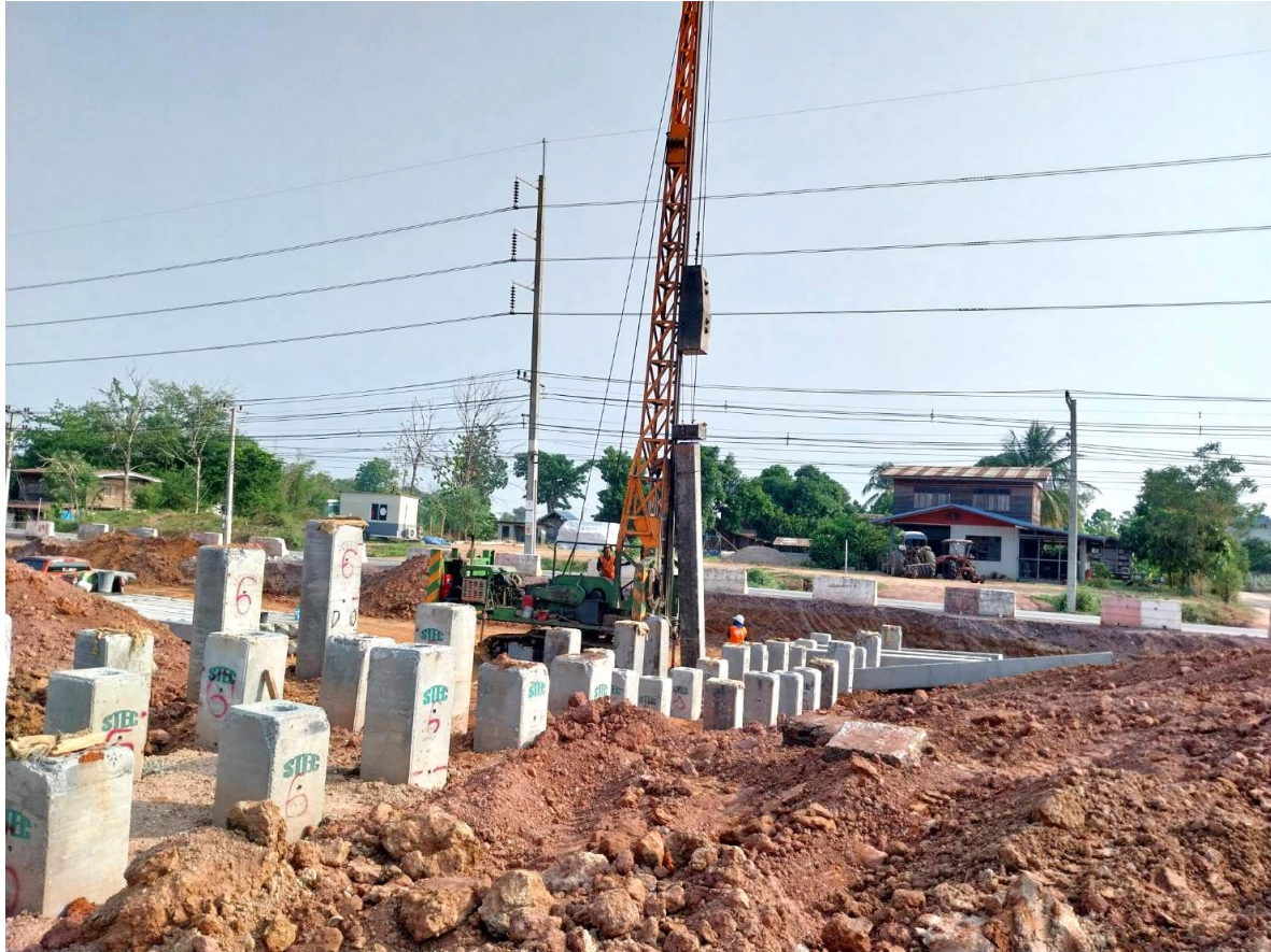
ก่อสร้างทางหลวงหมายเลข 24 อ.ปรางค์ชัย (นครราชสีมา)
