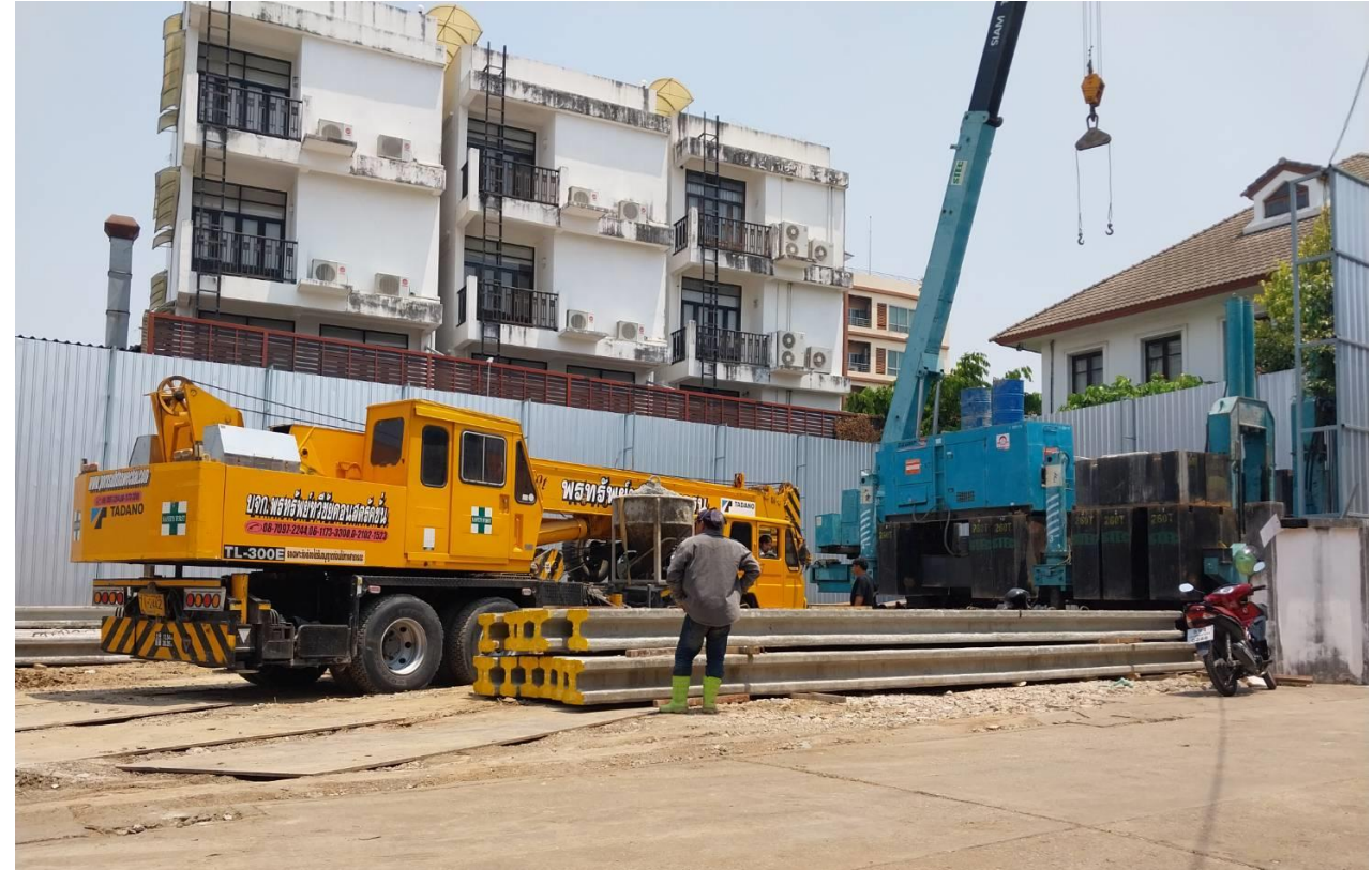
ก่อสร้างบ้านคุณหมอพรศักดิ์ ปรีดีพนมยงค์ 18 (กทม.)
