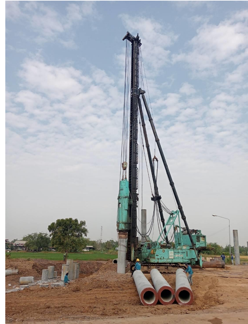
ก่อสร้างมอเตอร์เวย์บางปะอิน-นครราชสีมา (ตอน4)
