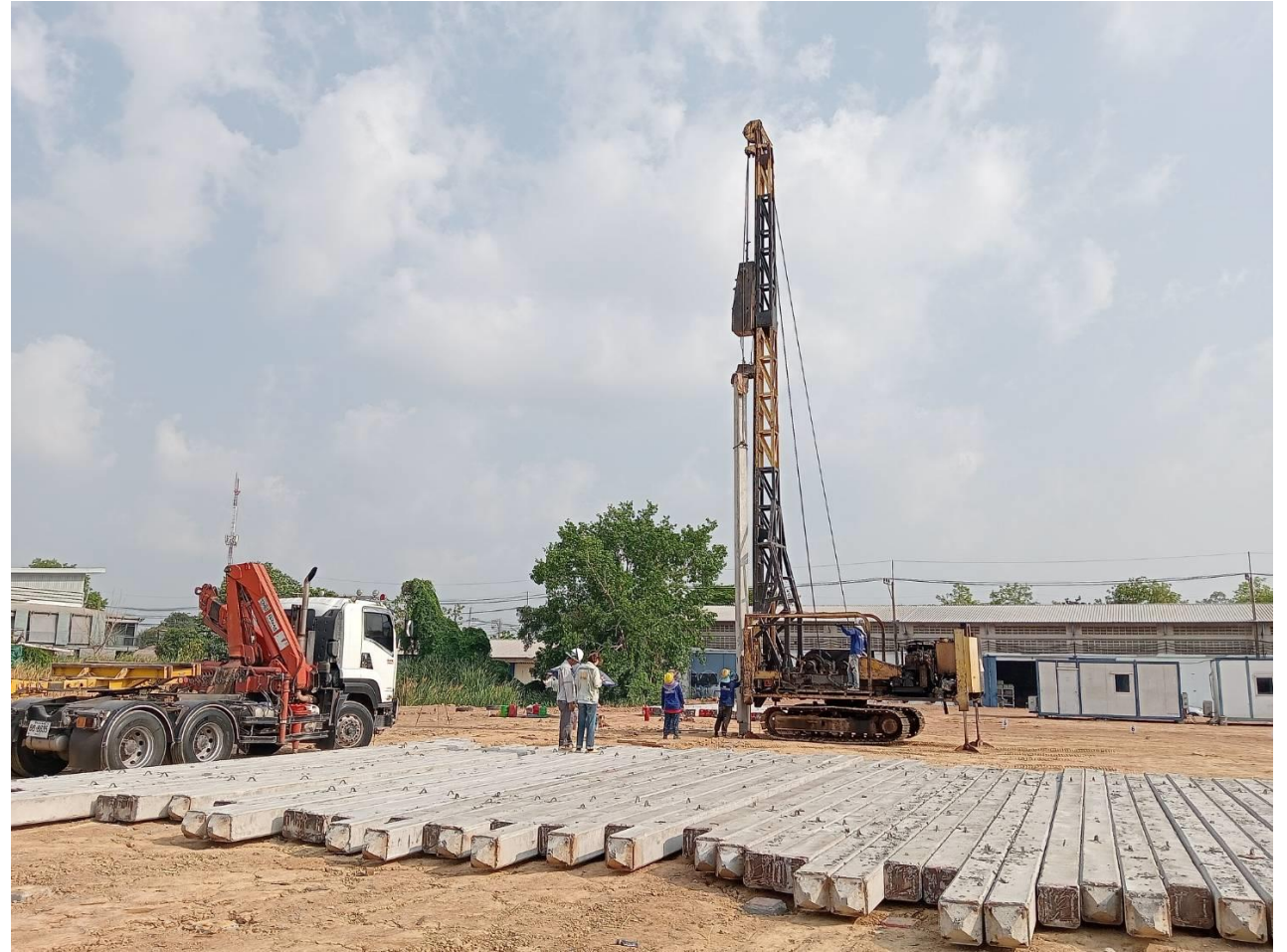
ก่อสร้างสถานีไฟฟ้า คลองหลวง2 (ปทุมธานี)
