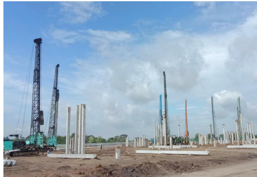
ก่อสร้างชุดคลองระบายน้ำหลัก พร้อมอาคารประกอบ สัญญาที่ 4 บางบาล-บางไทร อยุธยา
