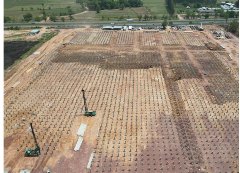
ก่อสร้าง TD Warehouse Buriram
