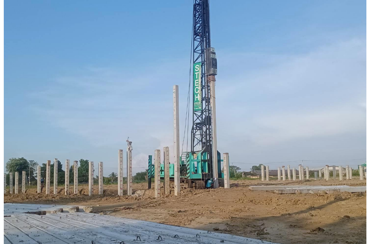
อาคารแปรรูปเนื้อไก่ จ.นครปฐม
